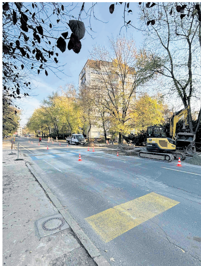
Prehod za pešce na Ljubljanski cesti bo odslej varnejši. (Foto: MOC)
