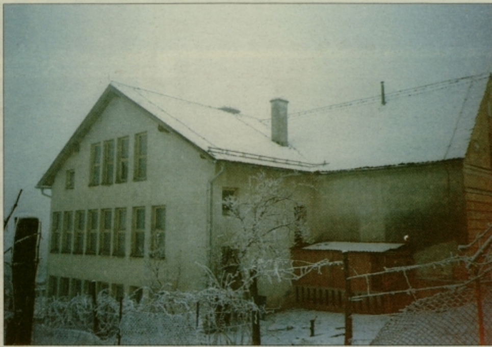
Na videz majhna stavba ima kar 442 kvadratnih metrov površine. Za šolo v zanimivi starinski podobi se namreč skriva veliki, moderni prizidek. Med hudim mrazom je bilo eno od oken kar odprto.
