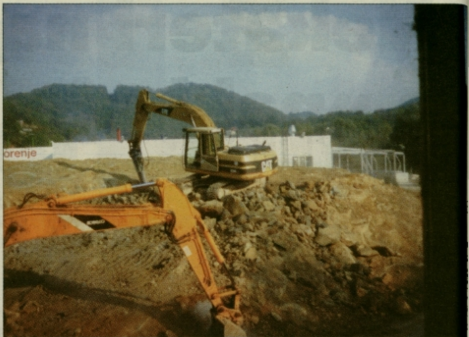
Izvajalci so se del sprva lotili s sekalcem, nato pa so nadaljevali z miniranjem.
