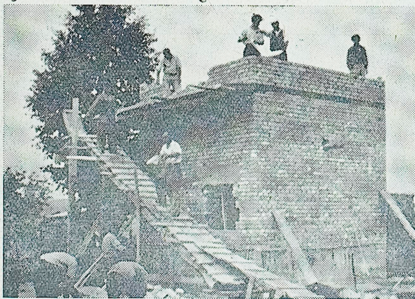
Gradnja ene izmed mnogih transformatorskih postaj po kraških vaseh
