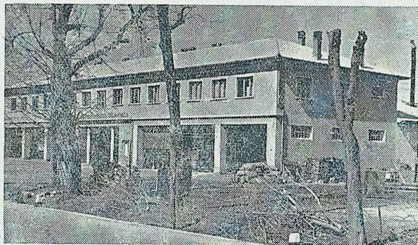
Mehanična delavnica v Sežani, ki jo je zgradilo podjetje »Kraški zidar«
