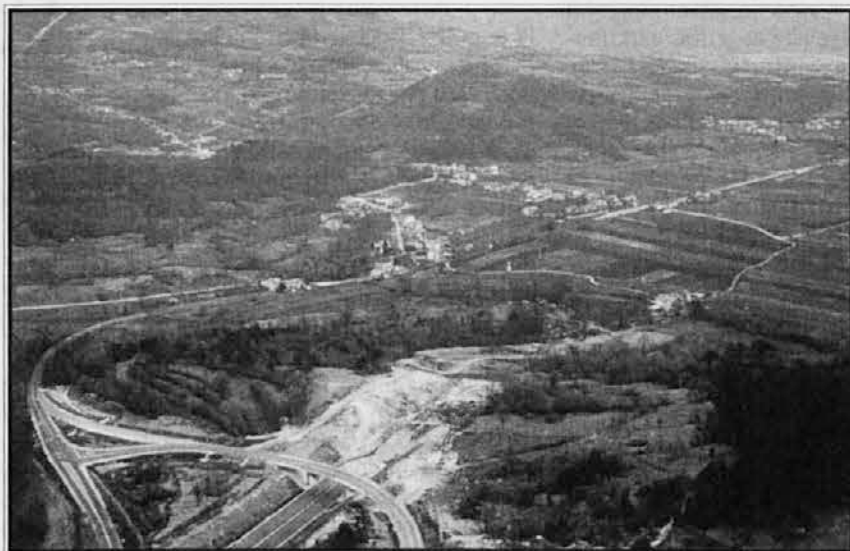
Letalski posnetek trase hitre ceste Vipava-Selo: pogled na že dograjeni odsek Selo-Sempeter in lokacijo viadukta Selo
