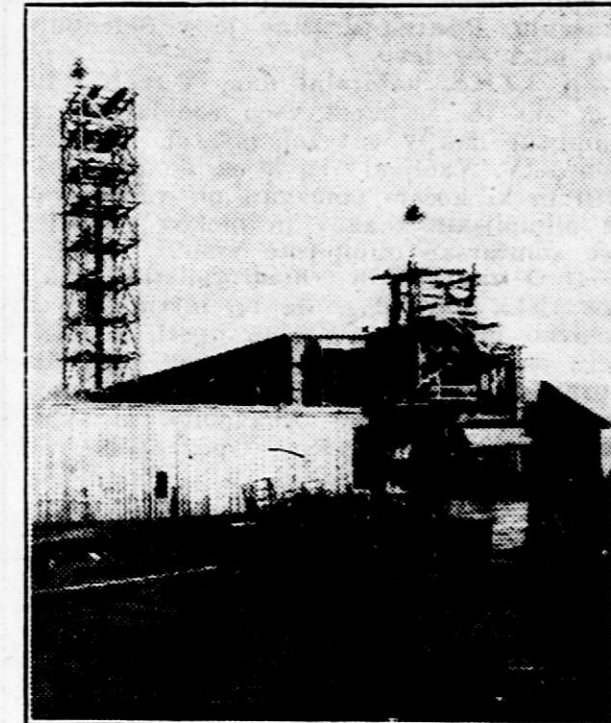
Postavljanje dimnika pri glavni stavbi
