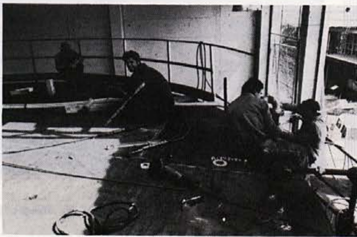
Popravilo cisterne za mazut. Tudi cisterna je popravljena in vzrok okvare odkrit.
