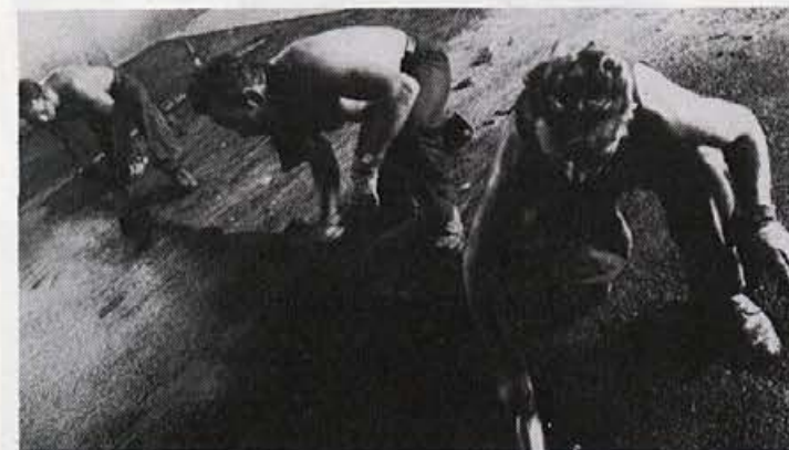
Ročno polaganje asfalta. To je bila ena od kritičnih aktivnosti rekonstrukcije, vendar nas »GORENJC« in »SLOVENIJA CESTE« nista pustila na cedilu.
