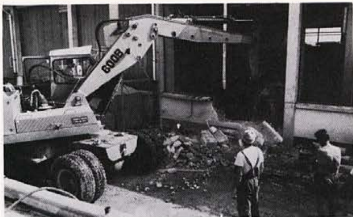
Rekonstrukcija se je začela — podiranje je šlo hitro od rok.
