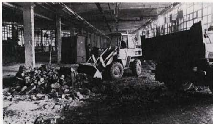
Prizadevni tržiški gradbinci so si pomagali z mehanizacijo, saj je bilo potrebno naložiti in odpeljati 300 kub.m materiala.
