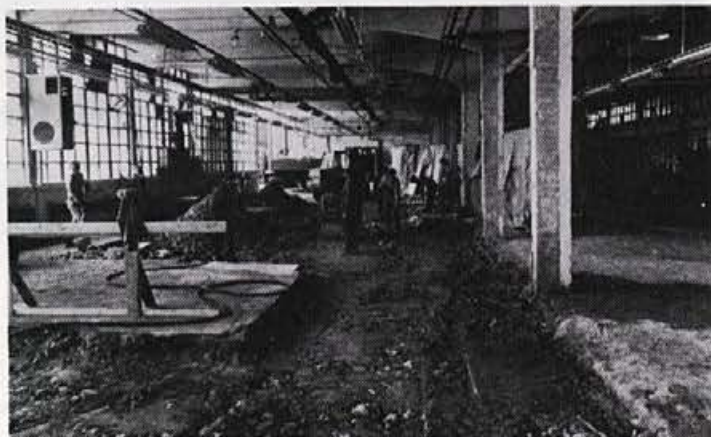
Začetek utrjevanja — priprava za betoniranje temeljev.
