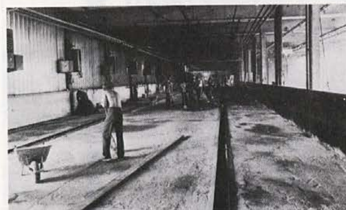
Kanali so zabetonirani, čaka še asfalt. Naši delavci ne bodo več delali v lužah.
