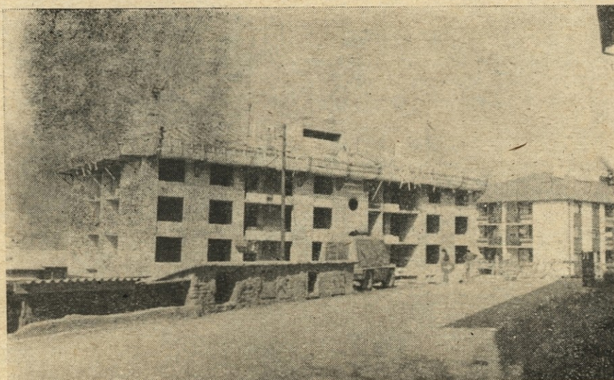
V Koloniji 1. maja v Trbovljah je v gradnji B blok za stanovanja upokojencev. Dela gredo h kraju. Po vsej verjetnosti pa se bodo prvi stanovalci vselili v ta blok sredi leta.
