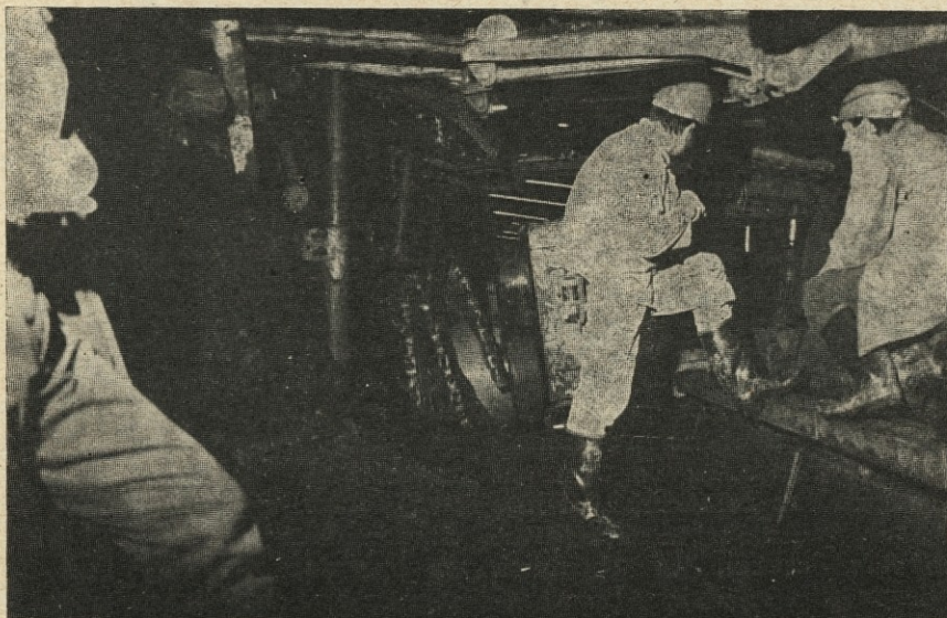
Jama TOZD Premogovnik Trbovlje, AB polje, samohodno hidravlično podporje Hydromarrel in rezalna glava Eitchoff.
