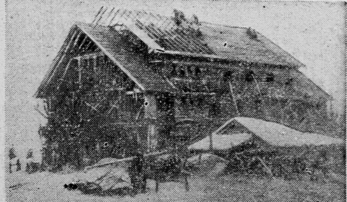
Na Polzevem pri Višnji gori bo še letos dograjen lep turistični dom. Znano je, da je bil na tem kraju tak dom že pred vojno, ki so ga pa Italijani med vojno požgali. Novi dom je začel graditi Okrajni ljudski odbor Ljubljana okolica lani oktobra. Konec decembra je bil dom dograjen do tretje faze. Dom stoji na istem kraju kot pred vojno, toda je enkrat večji, njegova ploščina je 26 x 17 m in 2-nadstropen. V njem bo prostora za 60 postelj, imel bo veliko jedilnico in kuhinjsko sobo, dom gradi z veliko vneto in zelo kvalitetno kolektivno Dolenjskega gradbenega podjetja Iz Grosuplja. Dom bo dokončan najkasneje do 1. septembra. Njegovo graditve toplo pozdravljajo dolenjski pa tudi ljubljanski turisti.
