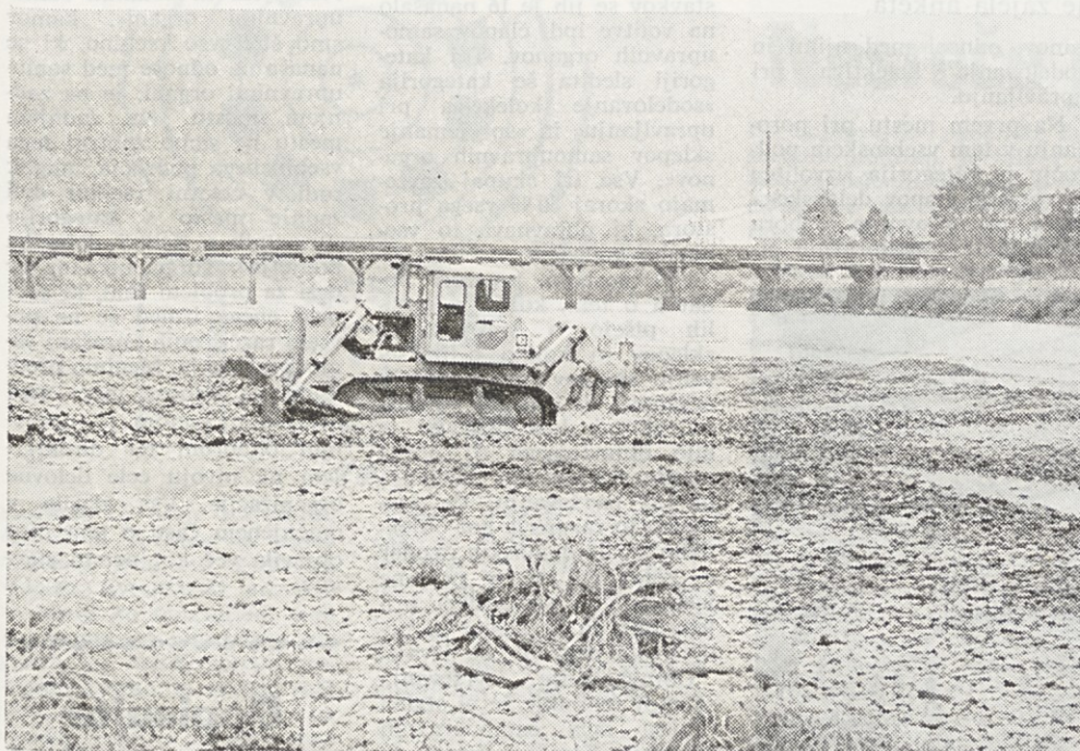
Most bo! Litija ga je potrebovala že pred leti, a nikoli ni bilo denarja. GP Gradis iz Ljubljane je že pričelo pripravljati teren.
