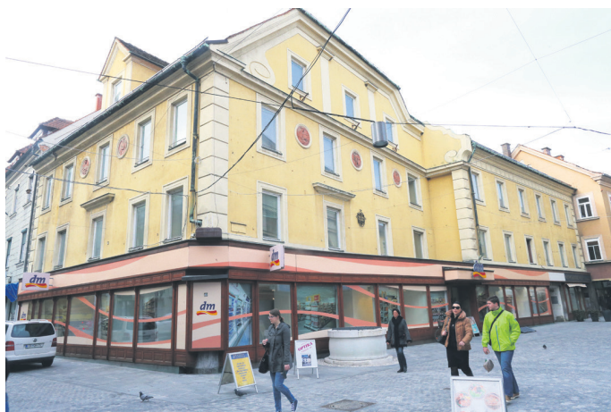
Od leta 2018 je podjetje Merkscha tudi lastnik znamenite stavbe na celjskem mestnem križu. Kdaj jo bo lahko začelo obnavljati in kakšna bo njena nova vsebina, še ni dokončno določeno. Marsikaj bo odvisno od uspešnosti izvedbe stanovanjskega projekta, ki ga podjetje načrtuje v Kocenovi ulici.
