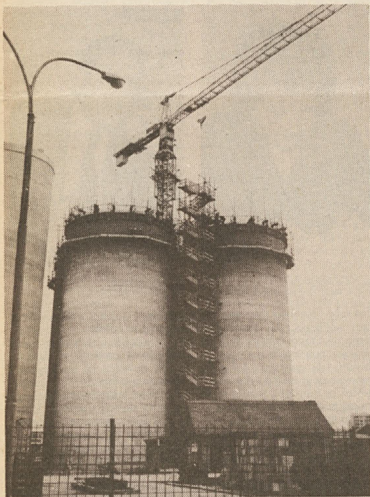
Še dva dni in silos bodo do vrha. Na posnetku je gradnja 4 celic silosov tik pred zaključkom. Tehnologija »vlečenja« silosov je takšna, da poteka betoniranje silosov neprekinjeno. Tokratno betonažo je spremljalo dokaj spremenljivo vreme od tropske vročine na začetku in aprilske zime s snegom. Betoniranje je trajalo 11 dni od kote 0,00 do 34,42.
