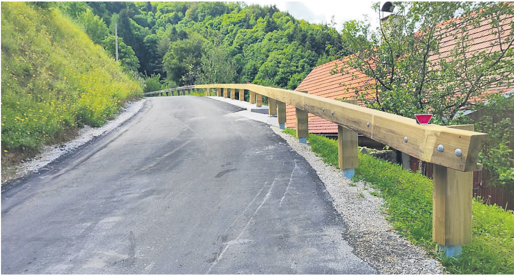
Podjetje Pavčnik je avgusta lani začelo s sanacijo plazu na cesti Ložina, konec leta so bila dela zaključena, otvoritev je sledila julija letos.
