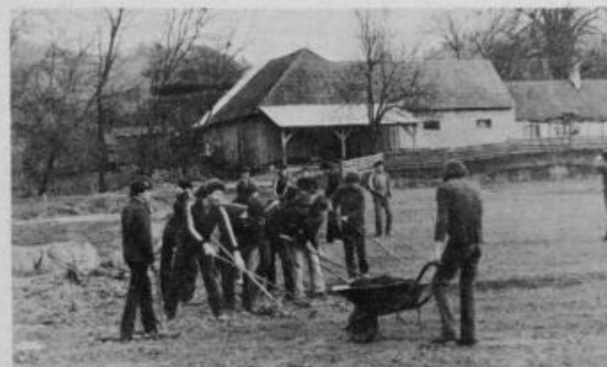
Pri dokončni ureditvi igrišča v Tržcu je sodelovalo veliko število mladincev, športnikov in gasilcev.
