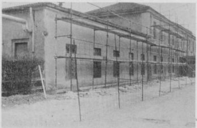
Začetek obnove fasade osrednje zgradbe železniške postaje v Pragerskem
