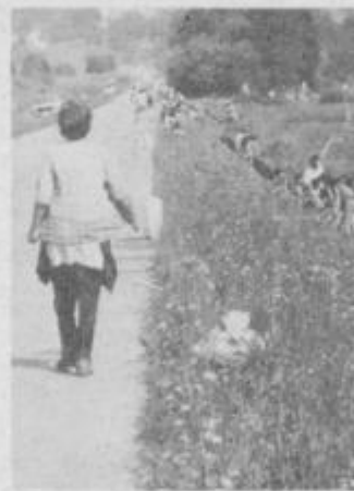
Delo na trasi. Brigadirji in domačini bodo izkopali 2400 m jarka za vodovod.
