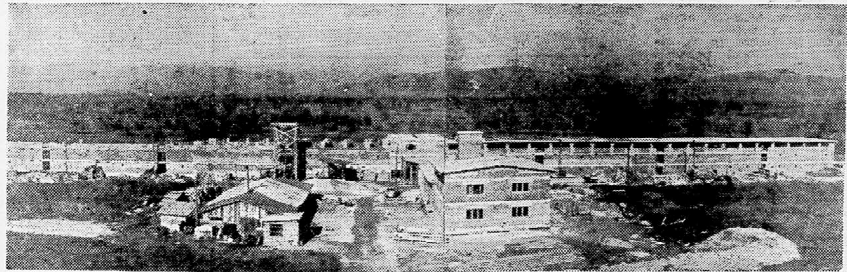
PERUTNINSKA FARMA V ZALOGU V IZGRADNJI
