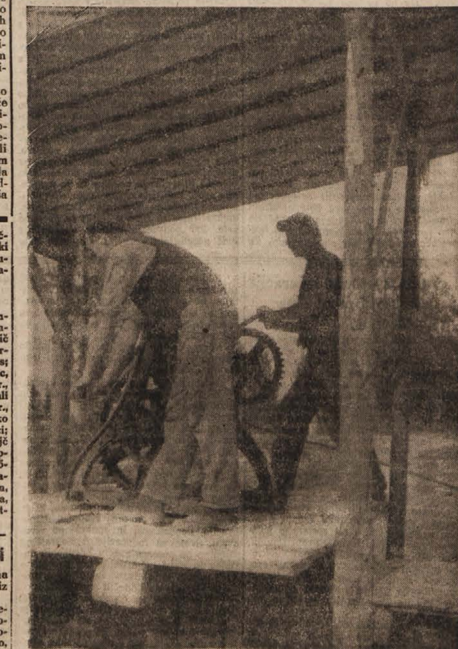
Rudnik v Kanizarici obnavljajo. Za prvo silo je postavljeno primitivno dvigalo.
