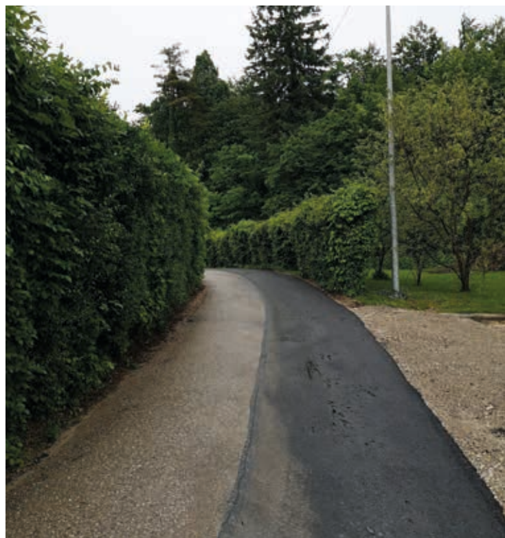
Asfaltiranje po obnovi vodovoda na Kremenici
