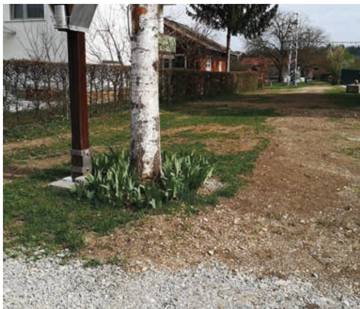
Po obnovi vodovoda v Kotu
