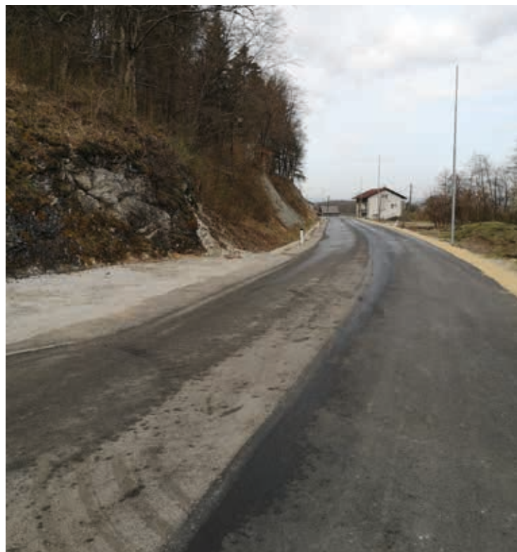
Zgrajeno je bilo javno kanalizacijsko omrežje in obnovljeni so bili vodovod in vodovodni priključki.
