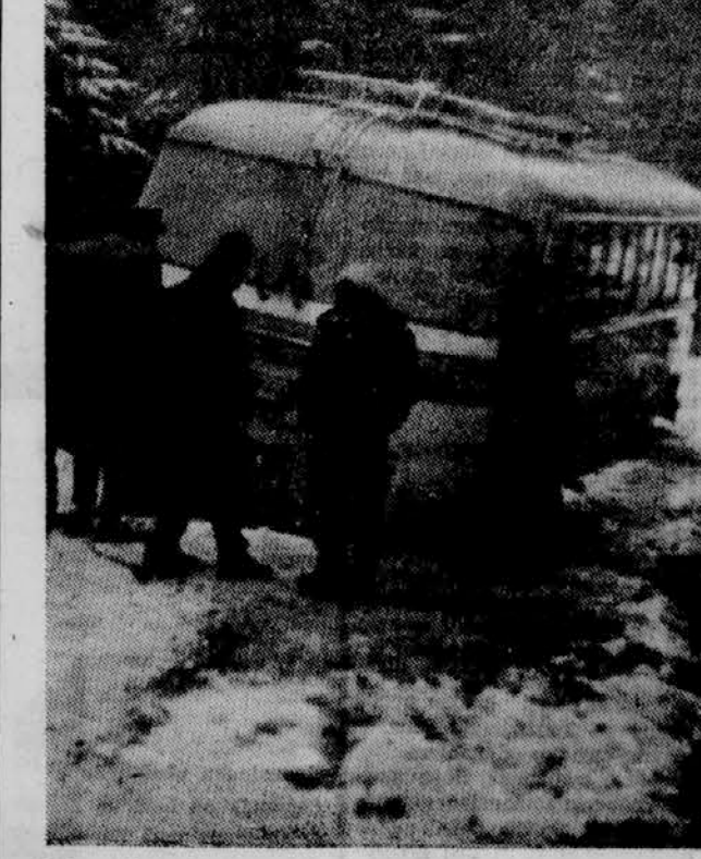
Ostra zima je letos močno poškodovala nekatere naše ceste. Med možno prizadetih je cesta Nova Štifta—Gornji les, po kateri vozi avtomobilski promet in delavci iz Zgornje Savinjske doline na delo v tovarno Litostroja. Zmrzalna liovnata podlaga je cesto na več mestih zgrabilila. »Čista kipi...« — pravijo ljudje. Avtomobil Ljubljana—transporta je v zadnjem času že večkrat do oai obljubil sredi cestnika. Doslej se je k sreči vse skupaj končalo brez posledica. Foto: Pogačar
