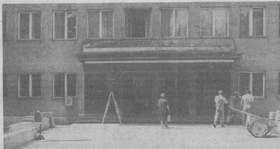
Zadnja dela pred vhodom v stavbo občinske skupščine
