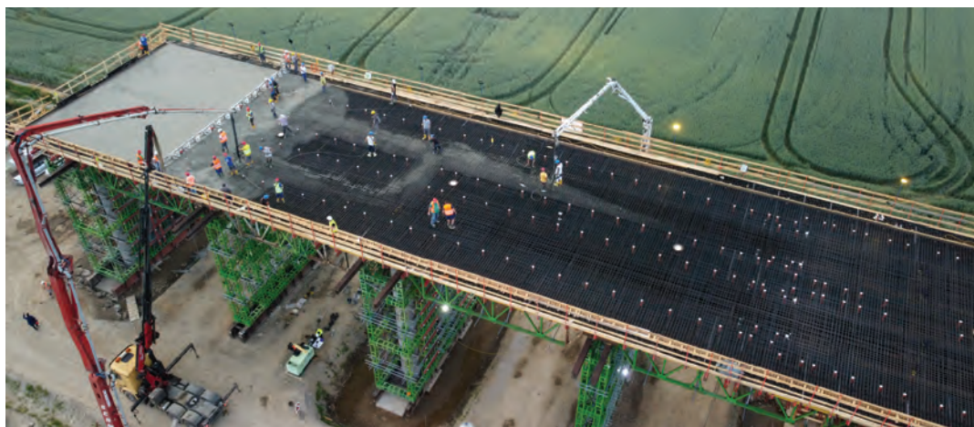
Novi viadukt Pesnica bo 900 metrov dolg železniški dvotirni viadukt, ki bo stal vzhodno od obstoječega. (Foto: DRSI)
