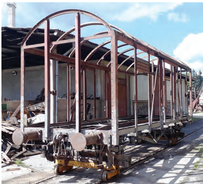
Naš vagon »slečen« in speskan, pripravljen na montažo nove lesene oplate.
