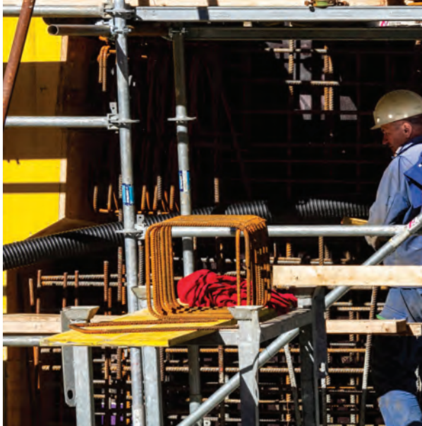
Dela na gradbišču predora T7, na katerem zaposleni konzorcija Kolektor CPG s partnerjema Yapı Merkezi in Özalpin vgrajujejo primarne predorske obloge.
