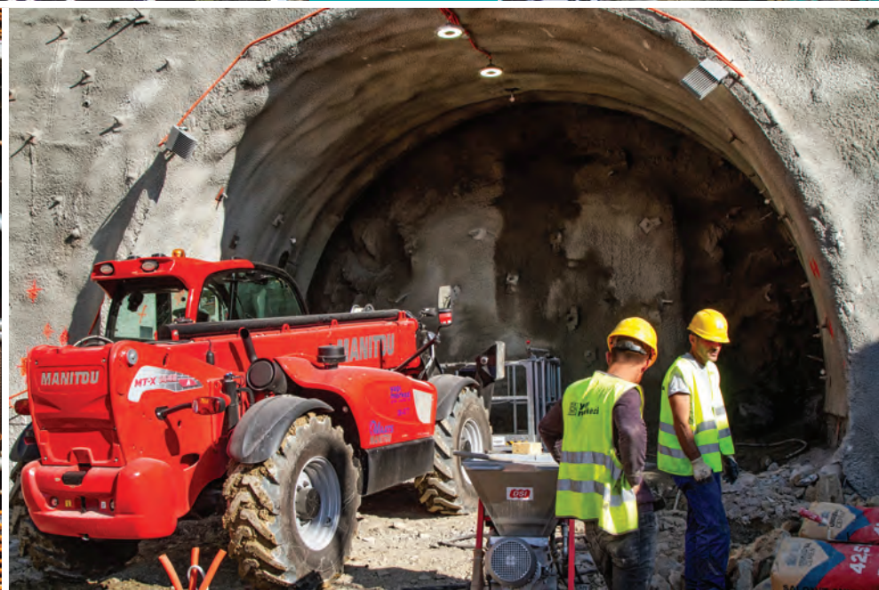
Dela na gradbišču predora T7, na katerem zaposleni konzorcija Kolektor CPG s partnerjema Yapı Merkezi in Özalpin vgrajujejo primarne predorske obloge.
