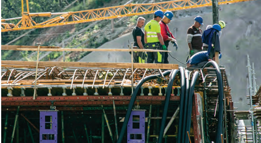
Skupaj z viaduktom Glinščica, ki bo pokrit, bo imel potnik na vlaku občutek, kot da se pelje v predoru, dolgem 13 kilometrov. Dela opravlja konzorcij družb pod vodstvom podjetja MarkoMark Nival.
