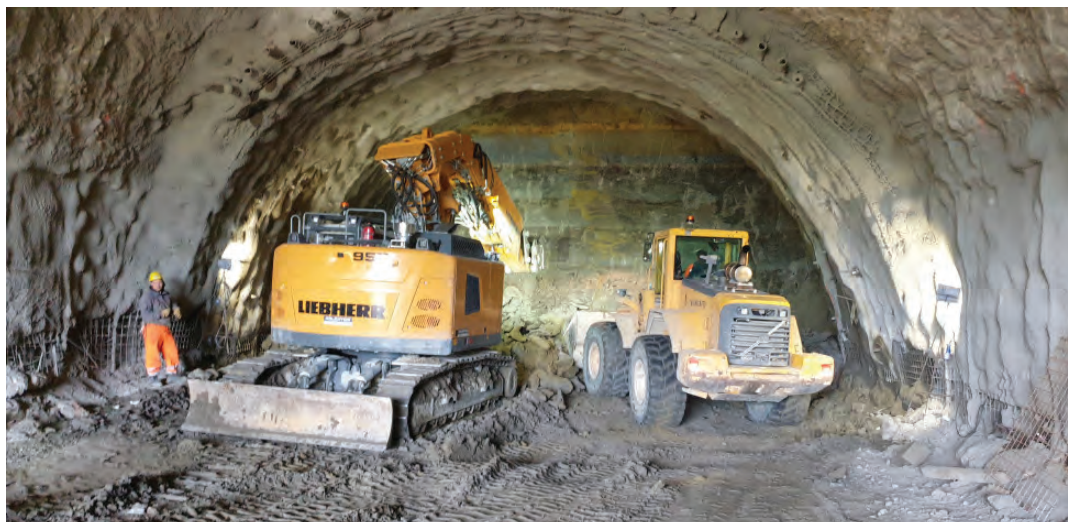
V predoru Pekel nadaljujejo izkopavanje ter izdelovanje kalote, zgornjega dela predora. (Foto: DRSI)
