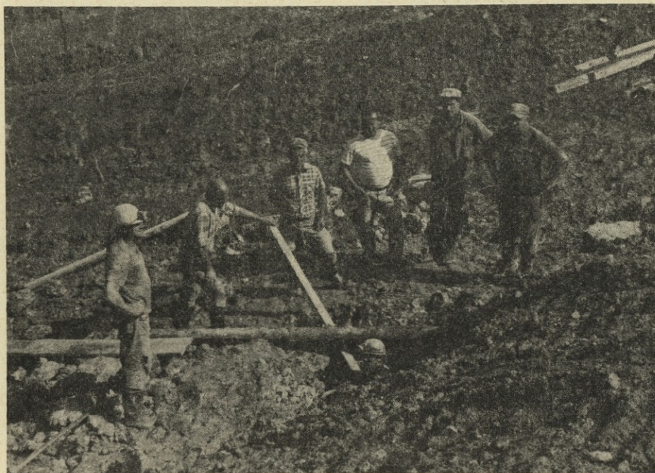
Preboj oskrbovalno-zračilnega nadkopa v jami Dole na površino — rudnik Zagorje, v avgustu 1986.
