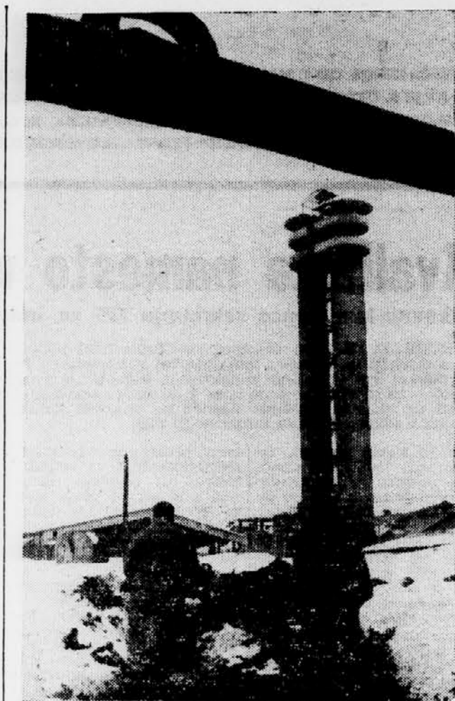
NAJVIŠJI STOLP NA SORSKEM POLJU — V poslovni enoti Tovarne celuloze in papirja Vevče — Medvedove v Goricih pri Medvodah so lani pričeli gradnjo nekaterih novih naprav. Pred letom dni so začeli obratovati novi kislinski stolpi — v njih se tvori kalcijev bisulfid, ki ga uporabljajo za kuhanje lesa — pred šestimi meseci pa tudi nova sortirna, kjer kuhano celulozo sortirajo in čistijo.
