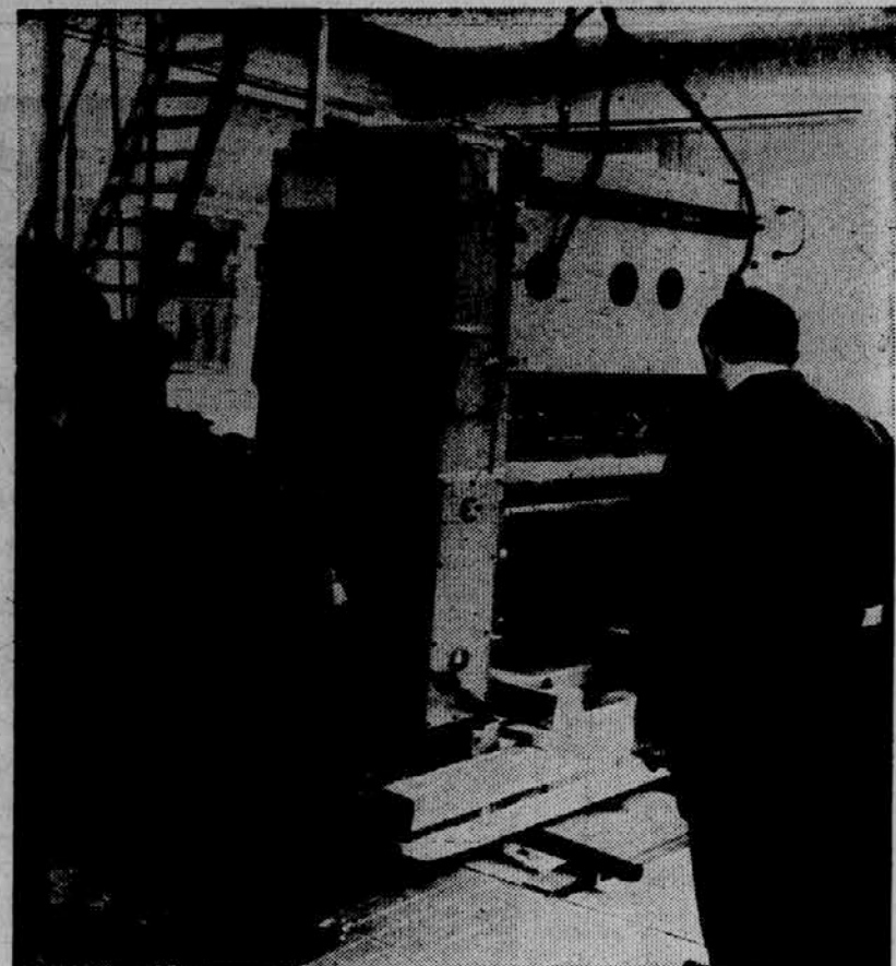
NOVA TEHNIKA ZA TISKARNO «DELA» — Včeraj so začeli montirati v novi tiskarni »Delas« na Titovi cesti prvi stroj za večbarvni offsetni tisk (na sliki). Do marca bosta postavljena še dva. Hkrati montirajo naprave v novem reprodukcijskem oddelku, ki bo med najboljše opremljenimi v Jugoslaviji. Foto: Svabić
