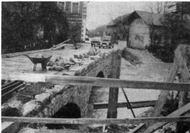
Kamnití most v Podbočju so popravljali ravno v času poplav. Za ta čas postavljeni zasilni most niže na vodi ni vzdržal vodne sile, nagnil se je, zaprl pretok in voda se je razlila do bližnjih hišnih pragov. Jezni krajani so most potegnili iz vode, nazaj pa ga ni bilo več treba postavljati, saj je bil kamnití takoj zatem že prehodan. Sedaj je popravilo tega mostu – tehničnega spomenika (levo) – že končano.
