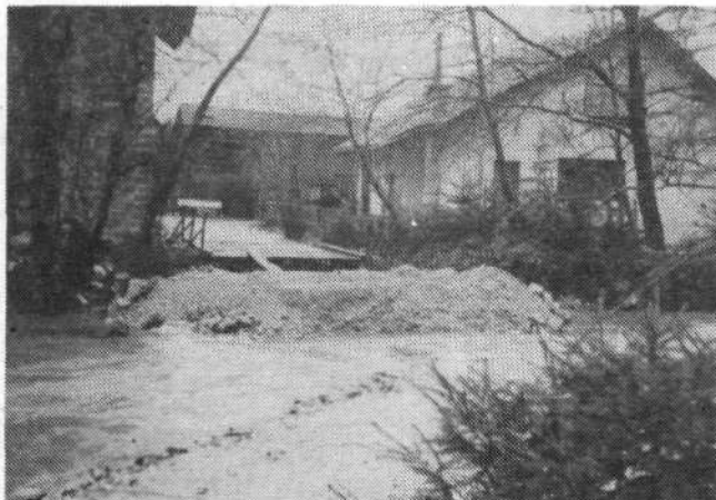
Kamnití most v Podbočju so popravljali ravno v času poplav. Za ta čas postavljeni zasilni most niže na vodi ni vzdržal vodne sile, nagnil se je, zaprl pretok in voda se je razlila do bližnjih hišnih pragov. Jezni krajani so most potegnili iz vode, nazaj pa ga ni bilo več treba postavljati, saj je bil kamnití takoj zatem že prehodan. Sedaj je popravilo tega mostu – tehničnega spomenika (levo) – že končano.
