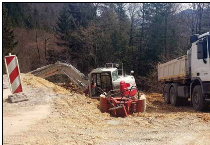
Sanacija plazu na lokalni cesti Prapreče-Lipa
