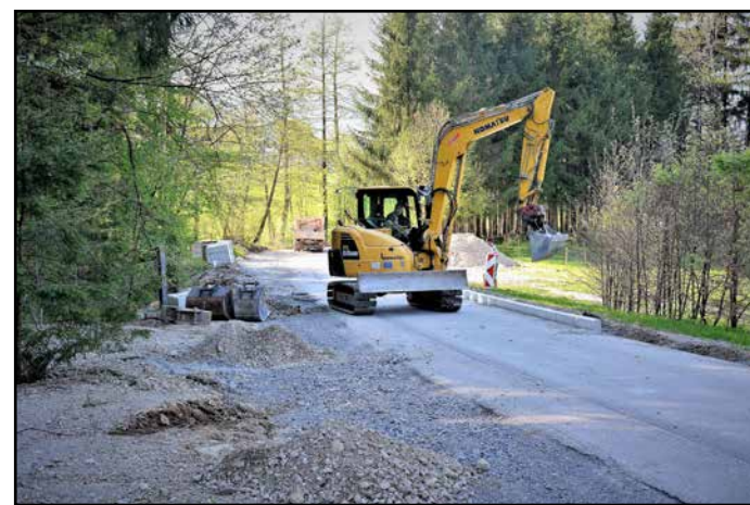
Dela na cesti Sv. Lovrenc-Lokavc že potekajo.
