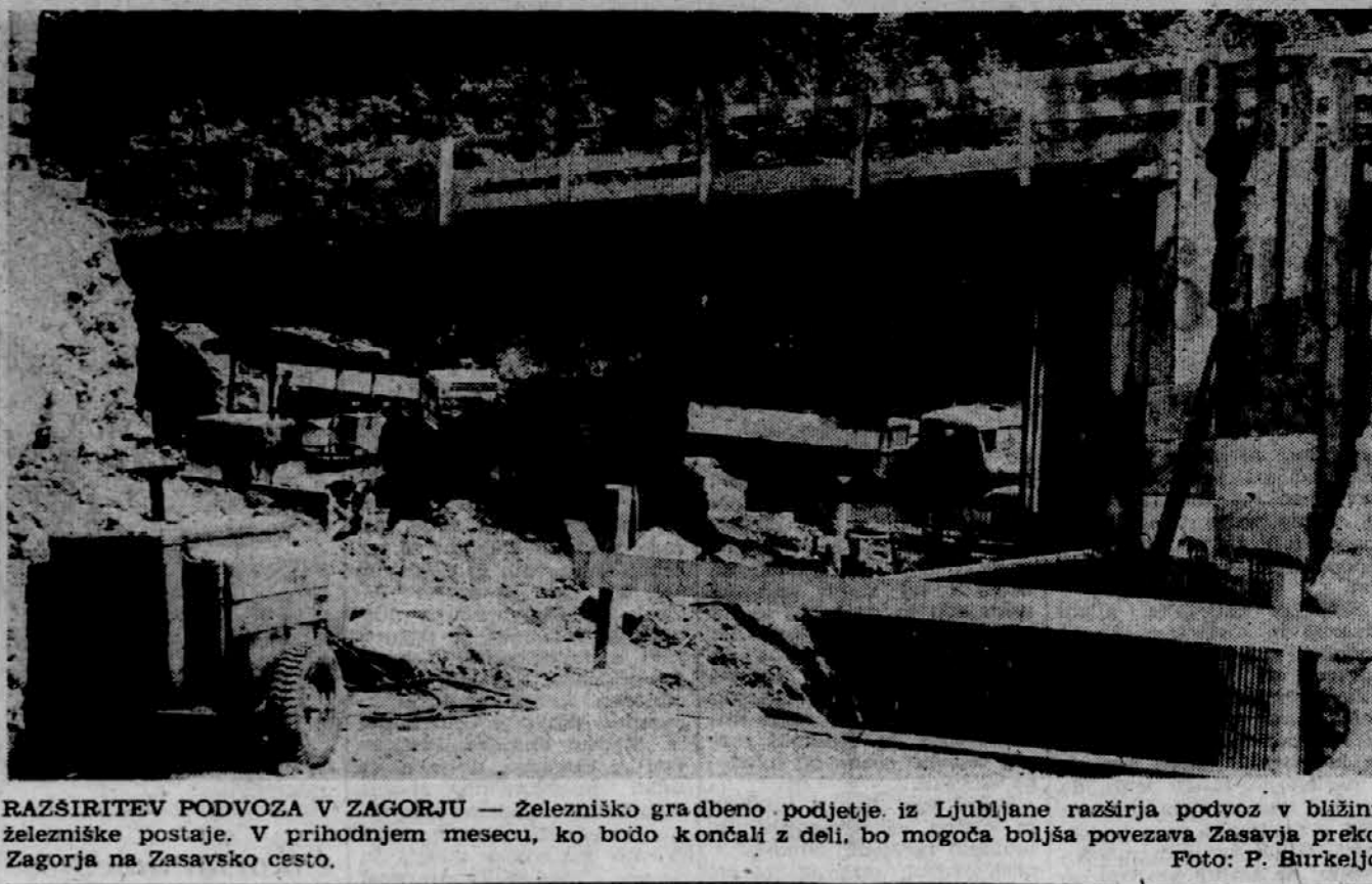
RAZŠIRITEV PODVOZA V ZAGORJU - Železniško gradbeno podjetje iz Ljubljane razširja podvoz v bližini železniške postaje. V prihodnjem mesecu, ko bodo končali z deli, bo mogoča boljša povezava Zasavja preko Zagorja na Zasavsko cesto.
