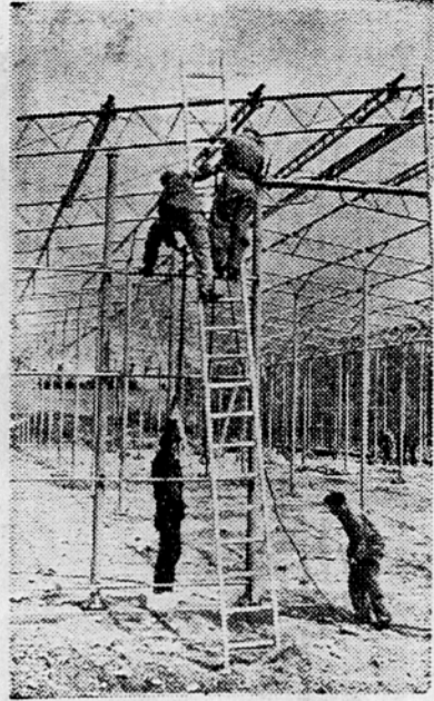
Na gradbišču Gospodarskega razstavišča v Ljubljani: V lesenem opazu mala razstavna dvorana, ki bo imela lupinasto streho; notranjost velike razstavne dvorane v prostorih bivšega podjetja »Mineral«, kjer bo v soboto odprta lovska in ribiška razstava; ograje tako imenovane montažne dvorane je sestavljeno iz brezšivnih cevi, izdelek železarn v Sisku.
