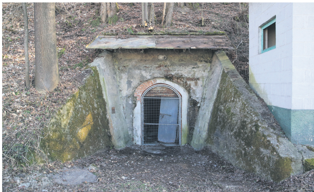
S stanjem zaklonišč in z njihovim urejanjem v zadnjih desetletjih se na splošno Celje in Slovenija ne moreta pohvaliti.
