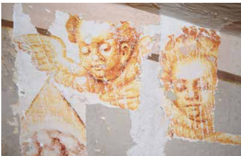
Cerkev sv. Roka, detajl angelskih glavic, ki sta bili odkriti na zahodni steni nad korom.
