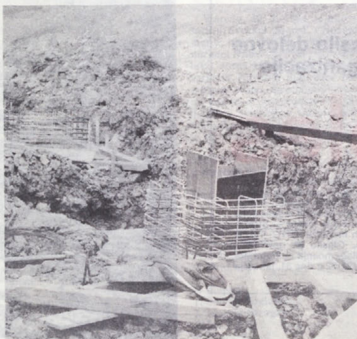
Temelji obrata Radatoviči
