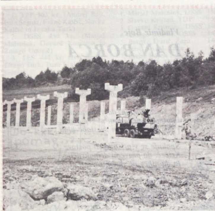
Podporni stebri hale v Radatovičih
