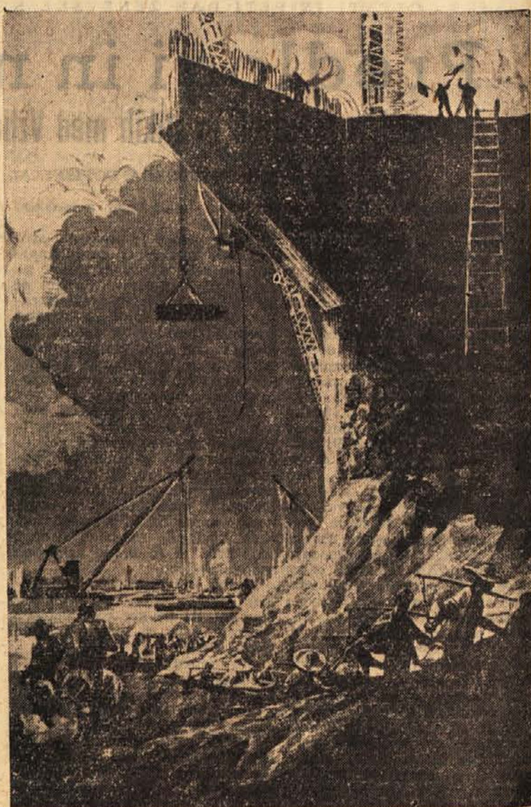
Gradnja mostu na reki Han
