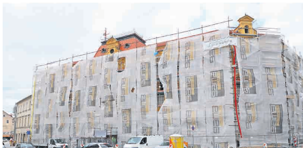
Na upravni enoti v Slomškovi ulici je gradbišče od februarja. S 512.000 se je vrednost prenove v tem času povišala na 692.000 evrov.
