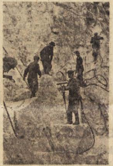
Mehka in položna je dolenska zemlja na prvi pogled, nemalokrat pa skriva v sebi kamen, ki mu ni konca. To so »bridko« izkusili tudi minerja na avtostradi »Ljubljana—Zagreb«
