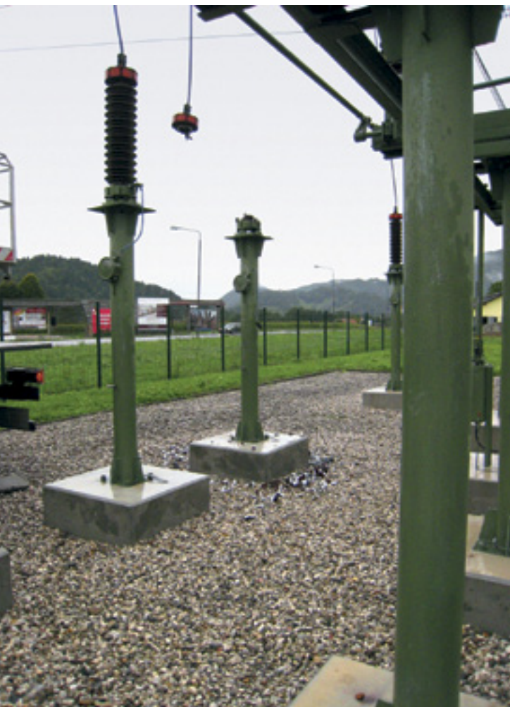
Poškodba prenapetostnega odvodnika v RTP Tržič.
