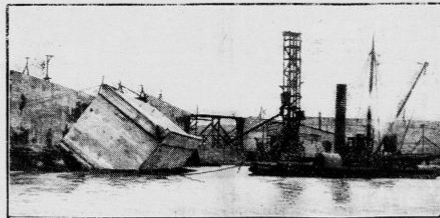
Prevračajoča se železobetonska skrinja. V ozadju že gotove skrinje.
