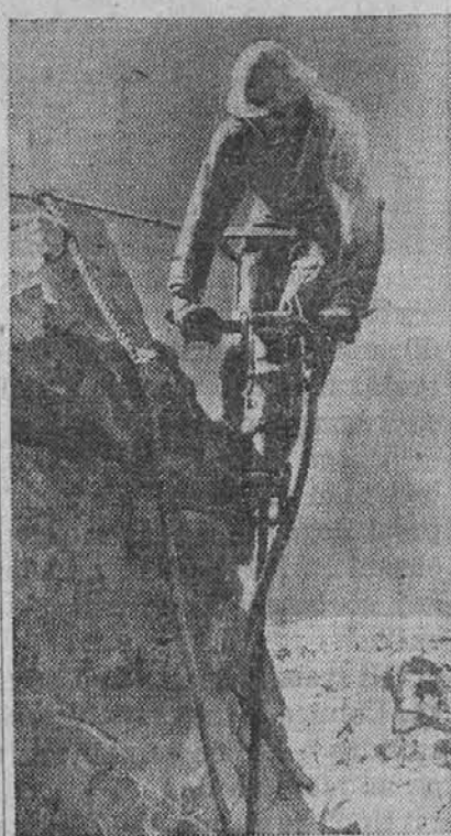
Na sliki vidimo delavca, ki vrta na visoki pečini luknjo za dinamiranje. Slika je bila posneta pri Shasta jezcu v Kaliforniji.
