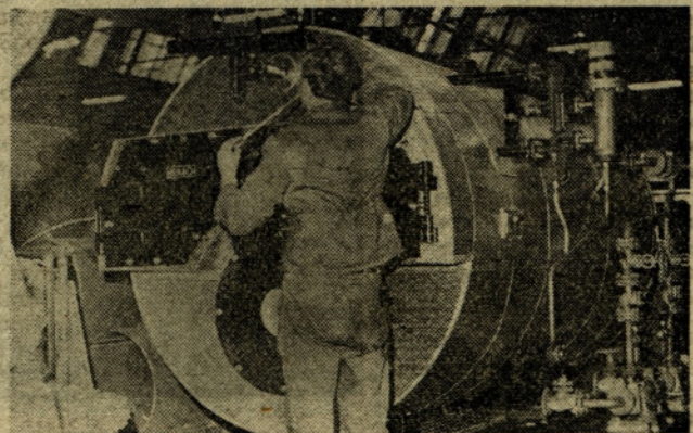
Zaključna dela na kotlu in že bo odšel h krajnemu koristniku
