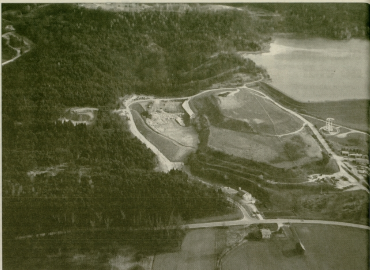
Večina novih objektov CERO bo zrasla za gozdičkom, levo od sedanje deponije in levo od dovozne ceste.
