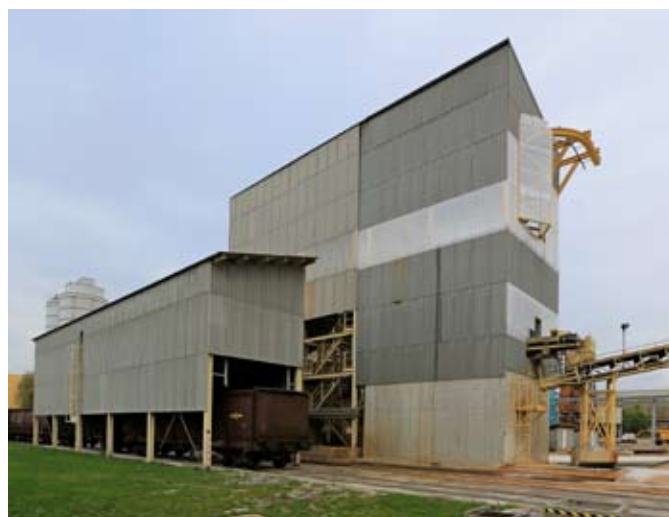
Končna podoba Proizvodnje Cegipsa (fotografija: Blaž Črepinšek)
