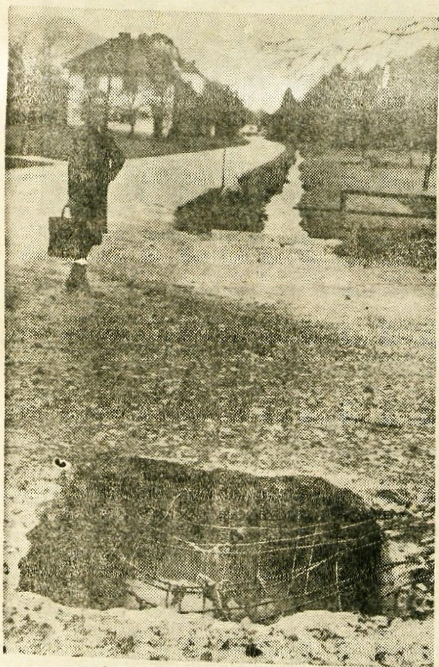
V Zg. Dupljah je pri gasilskem domu že pred časom avtobus poškodoval most. Nevarna vrtina še do danes ni popravljena. Prostovoljni gasilci v Zg. Dupljah pravijo, da bodo to poškodbo popravili skupaj z avtobusnim podjetjem SAP iz Ljubljane. Kaže pa, da so se o tem samo dogovorili in da se bodo del lotili šele, ko se bo zgodila nesreča. — Foto: F. Perdan
