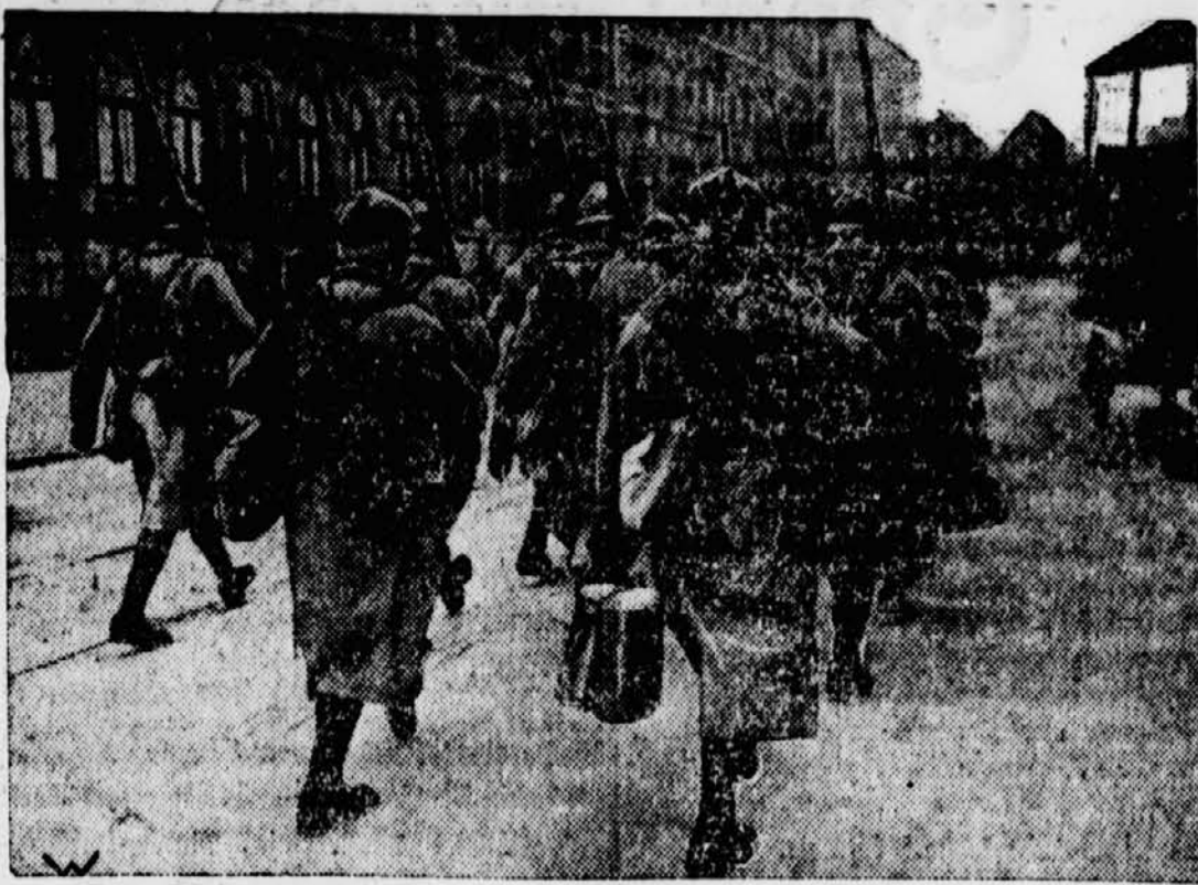
Die Räumung der Zone Dorimund-Hörde durch die Franzosen.
