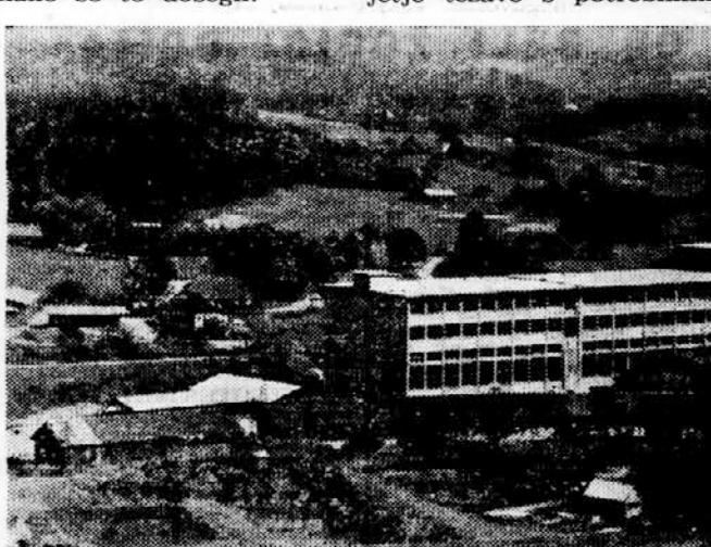
Pogled na novozgrajeno halo Tovarne usnja Šoštanj.
