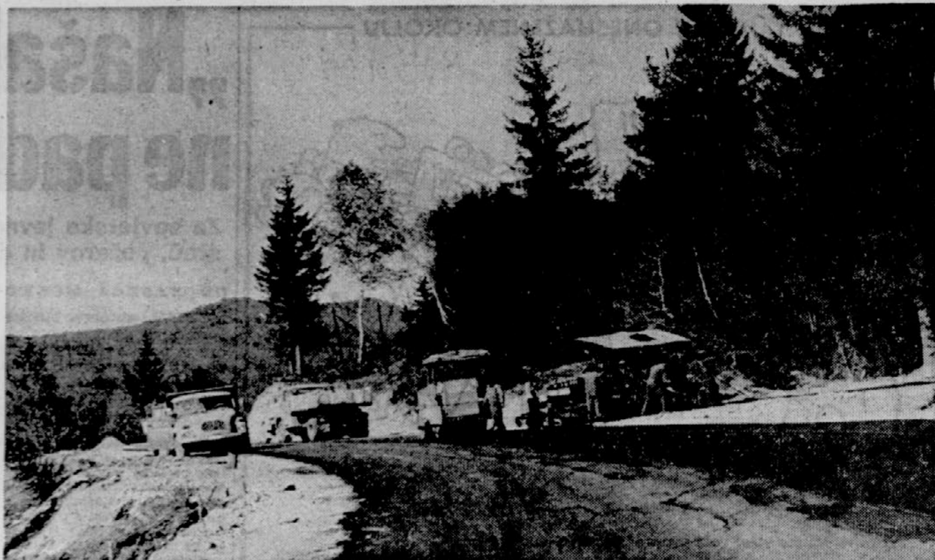
DELA NA CESTI KOČEVJE—BROD — Lani so začeli graditi cesto iz Kočevja proti Brodu in te dni končujejo dela na prvem odseku, dolgem 2,5 kilometra.
