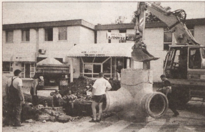
KANALIZACIJA V SREDIŠČU - Delavci sevniske Komune bodo do novega šolskega leta obnovili okrog 170 m kanalizacije v najožjem središču mesta med hotelom Ajdovec, HTC-jem in osnovno šolo Sava Kladnika. Zamenjujejo cevi z mnogo bolj propustnimi avstrijskimi (na posnetku), da ne bi ob večjih nalivih "plaval" v hotelu in še ponekod. Okrog 20 milijonov tolarjev vredno naložbo bodo krili s kanalsčino. (Foto: P. P.)
