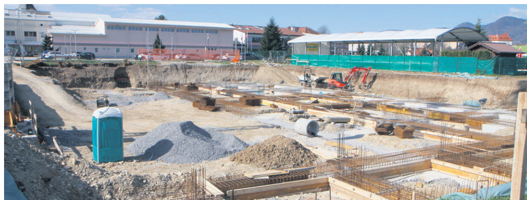
Pripravljalna zemeljska gradbena dela so se začela konec februarja. Trenutno izvajalec del, gradbeno podjetje Vodeja, opravlja izkop za gradnjo podzemne garaže. (Foto: TT)
