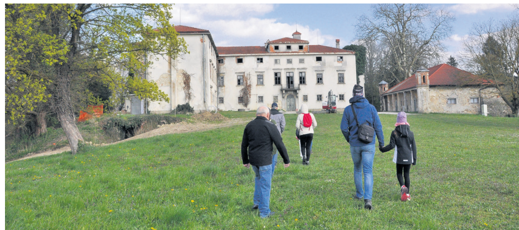
Jelšingrad je prizadelo več potresov, dolga leta je osamljen propadal. Zdaj je lastnica občina in poslopje bo deležno statične obnove in drugih obnovitvenih del.
