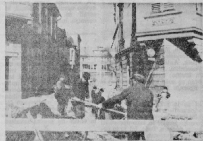
V Miklošičevi ulici polagajo nove cevi za kanal
