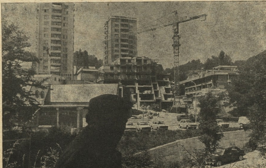
Pri Birtiču v Hrastniku grade nov poslovno stanovanjski objekt. Med tem so podrli tudi zgradbo pri križšču.
