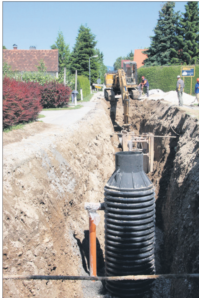
Štirje dodatni meseci »razkopanih« cest in zemljišč niso bili dovolj, da bi Vegrad in podizvajalci »pripeljali« gradnjo kanalizacije do konca. Potrebujemo še en mesec, ki je za nekatere nerealen čas za dokončanje del. Dela na kanalu v Braslovčah (na sliki)
