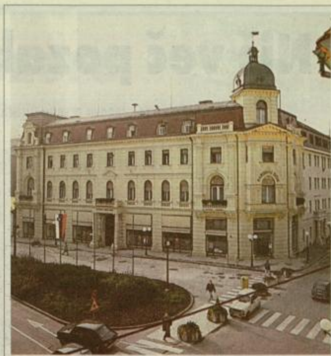
Celjski Narodni dom so Remontovi delavci prenavljali že večkrat, ureitvenih del pa se bodo lotili spet v kratkem, saj v Celju letos praznujemo 100-letnico dograditve te znamenite zgradbe.
