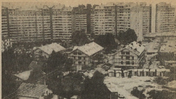
Trije majhni bloki znotraj »obzidja« 12-etažnih stolpnic.
